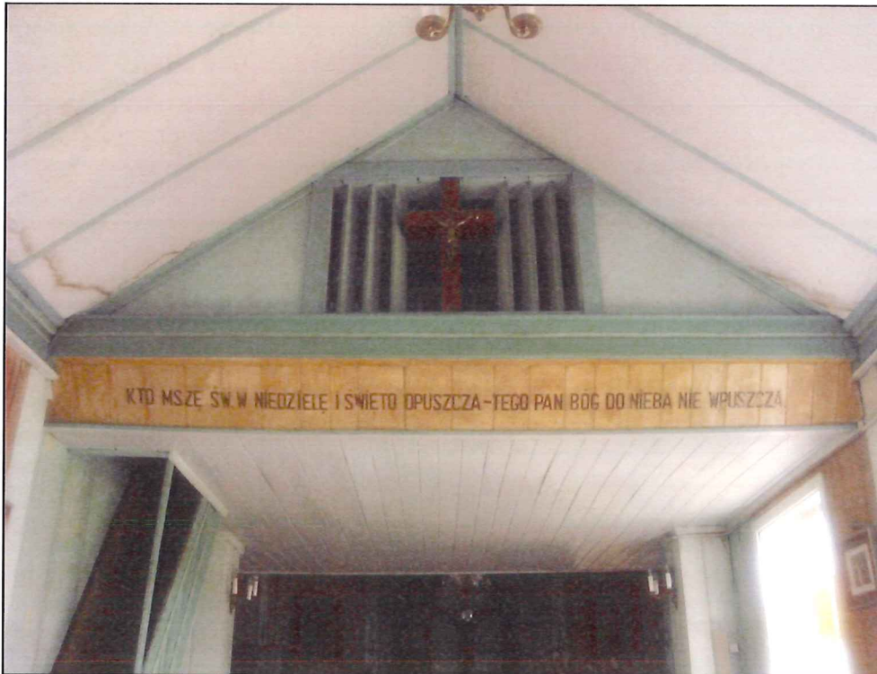
Foto 3. Widok na ściany czołowej nad wejściem do nawy głównej (trójkąt) i części sufitu w babińcu (obitych miękką płytą pilśniową) oraz odeskowanego sufitu pod chórem z bocznym wejściem na chór.
