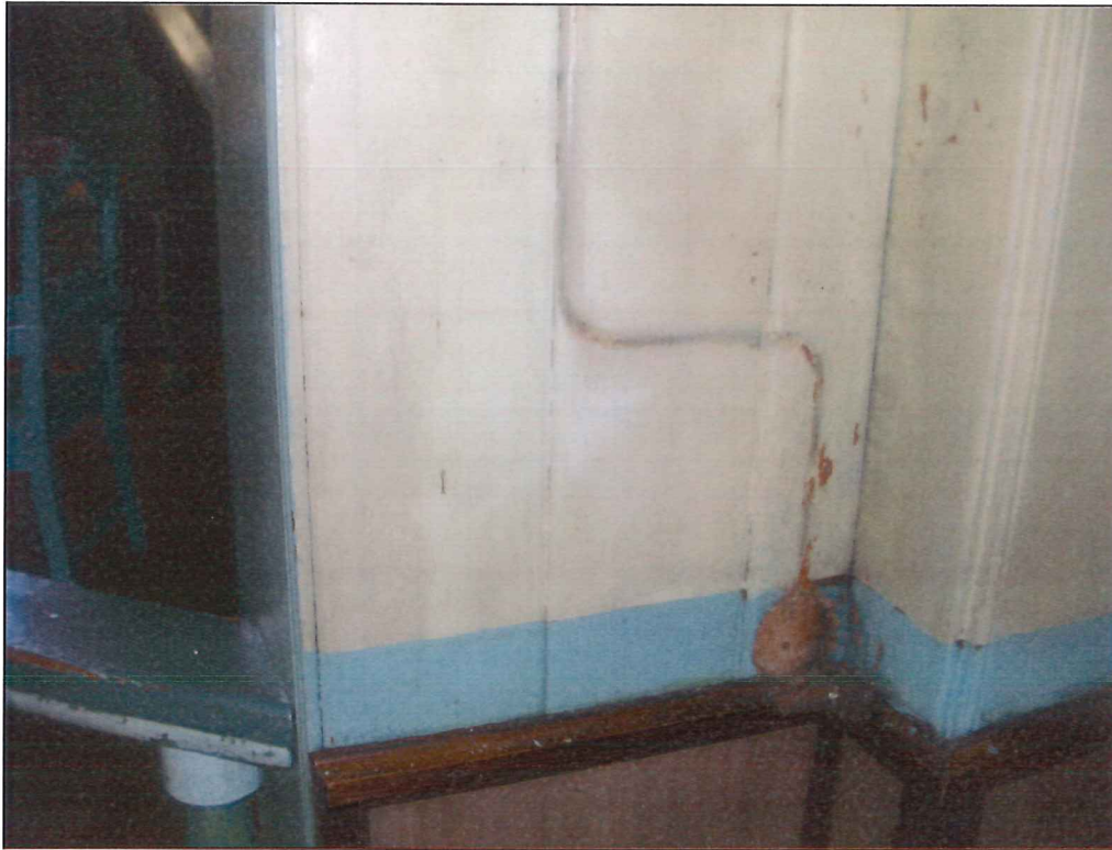
Foto 9. Widok listwowanej lamperii z laminowanej płyty twardej przed wejściem do kaplicy św. Tadeusza w kościele św. Rocha w Mroczkowie.
