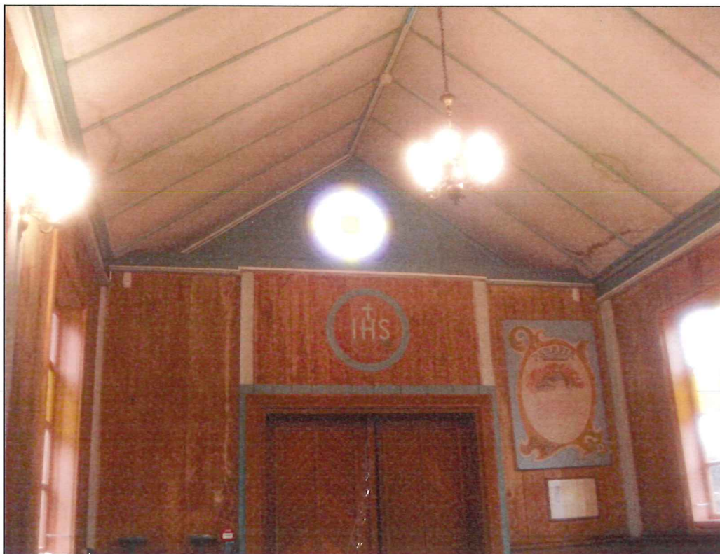
Foto 2. Widok ściany czołowej nad wejściem (trójkąt) i części sufitu w babińcu kościoła św. Rocha w Mroczkowie z obitych miękką płytą pilśniową.
