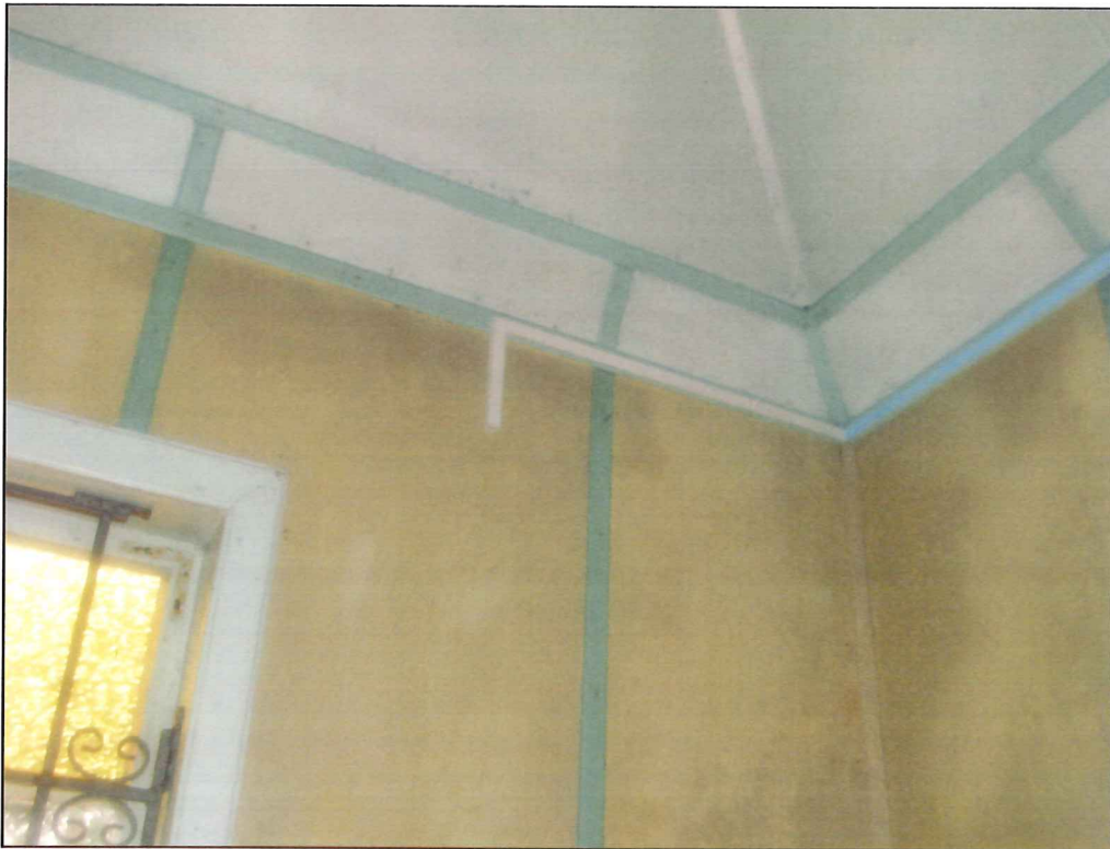
Foto 5. Widok ścian i części sufitu w kaplicy bocznej św. Tadeusza w kościele św. Rocha w Mroczkowie obitych miękką płytą pilśniową.
